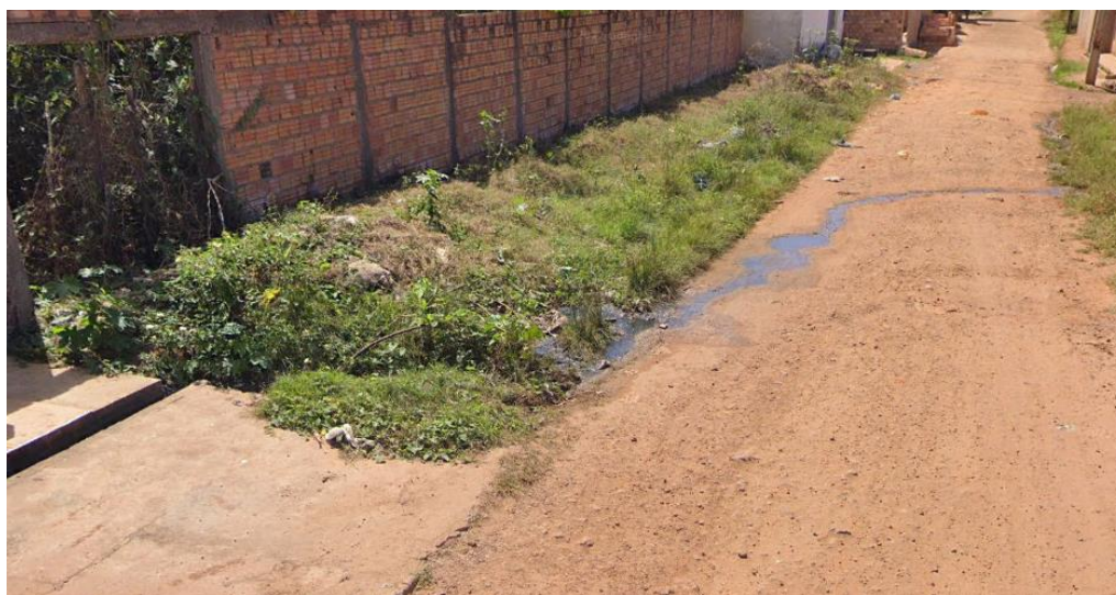
Figura 35. Escoamento de efluentes sanitários ao longo da Rua Nossa Senhora das Dores
