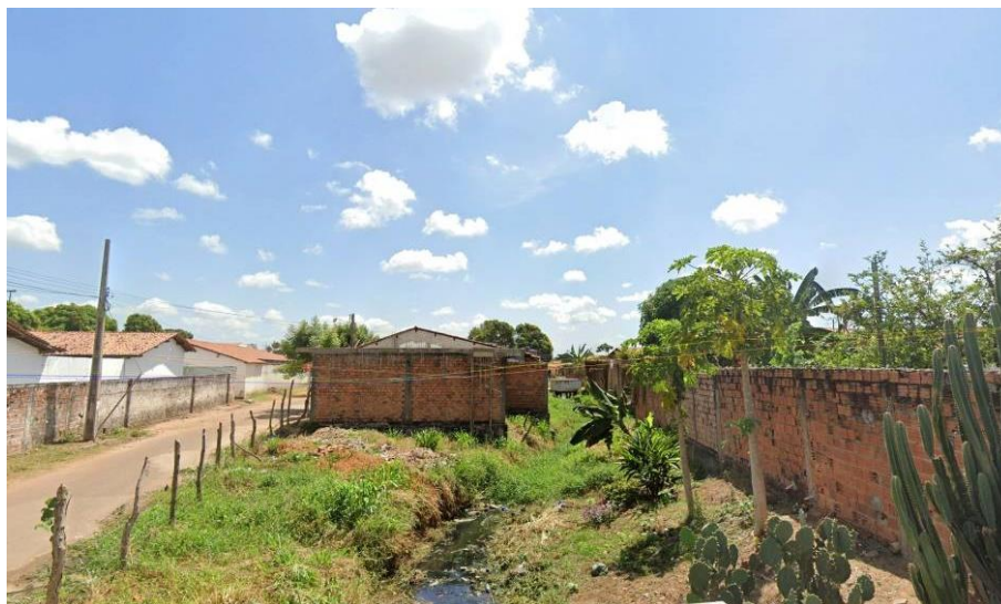
Figura 34. Vista de trecho do córrego Água Fria com esgotos em trânsito
