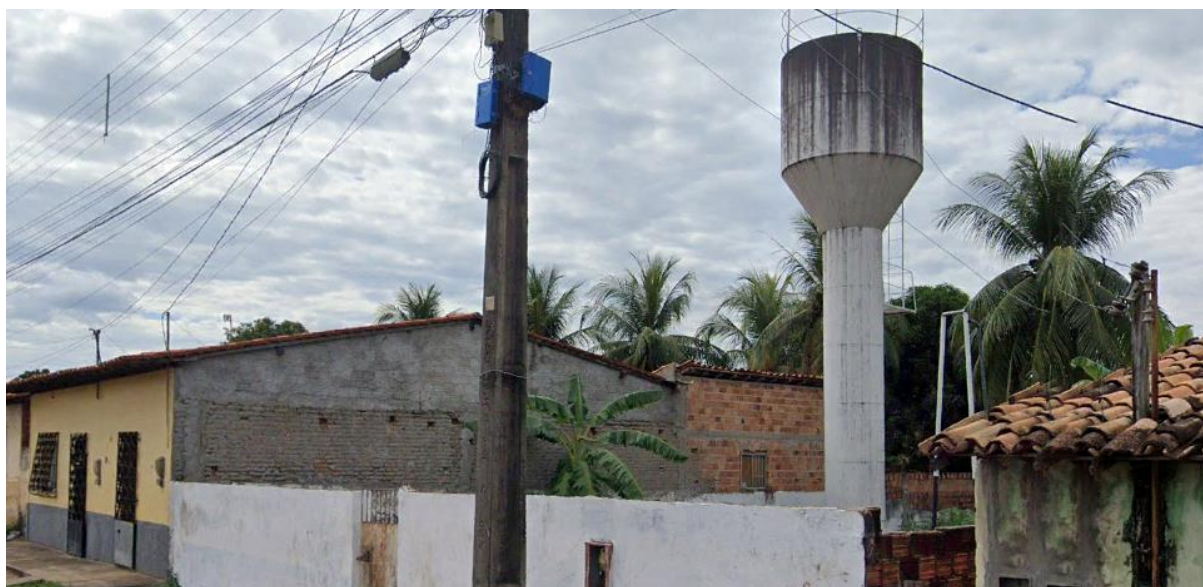
Figura 27. Sistema de reservação “Res-I”
