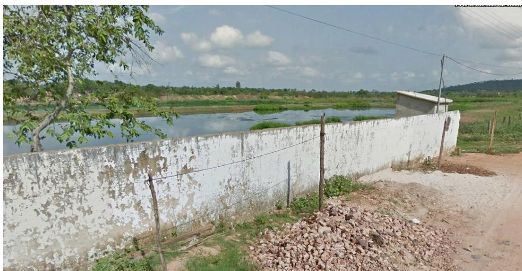
Figura 38. Vista da estação de tratamento de esgoto de Codó
