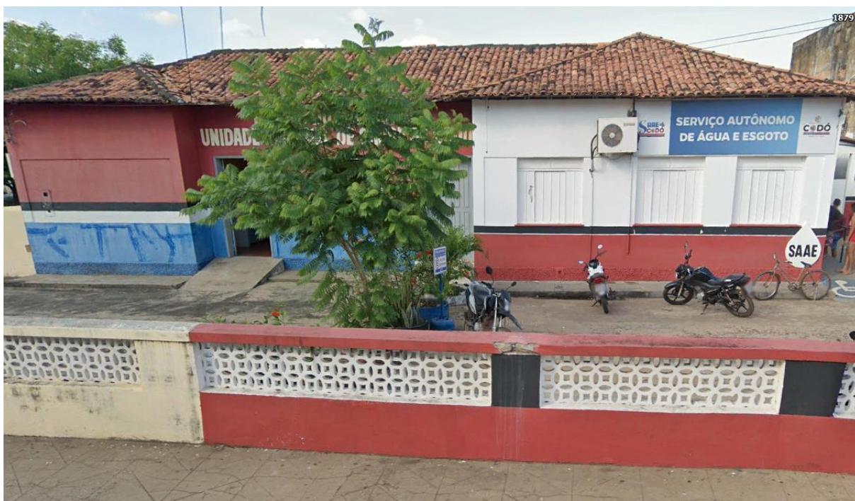
Figura 12. Sede administrativa do Serviço Autônomo de Água e Esgoto (SAAE)
