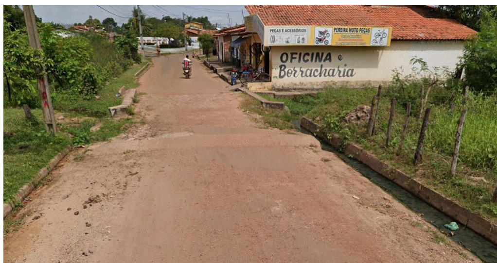
Figura 36. Escoamento de efluentes sanitários em valeta da Rua Frei Henrique de Coimbra
