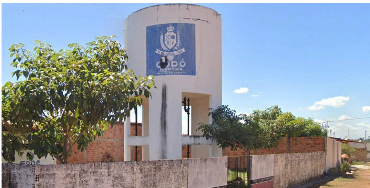
Figura 30. Sistema de reservação “Res-I”
