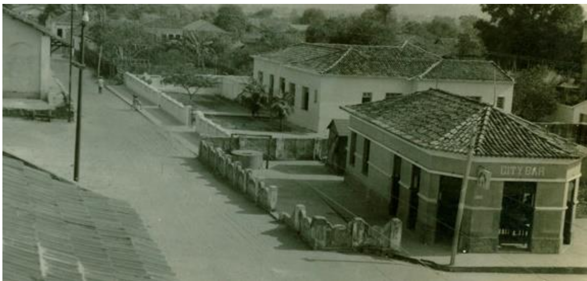
Figura 06. Avenida Primeiro de Maio (sem data)
