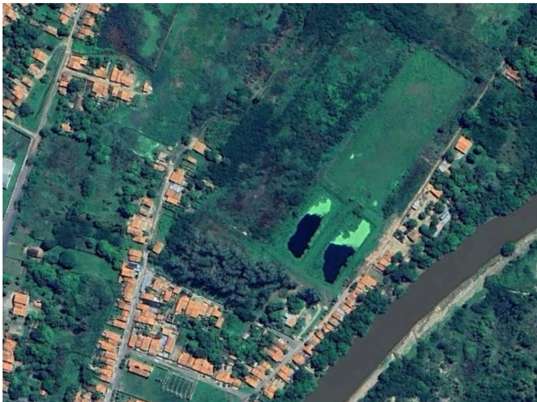
Figura 39. Imagem de satélite da área da estação de tratamento de esgoto
